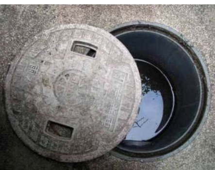
マンホールの中
